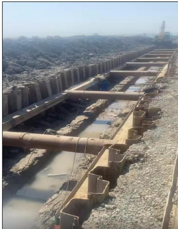
图 1.5-5 钢板桩围护结构示意图
